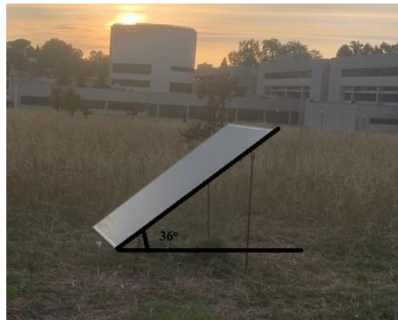
Figura 8 - Ângulo inclinação do painel fotovoltaico
